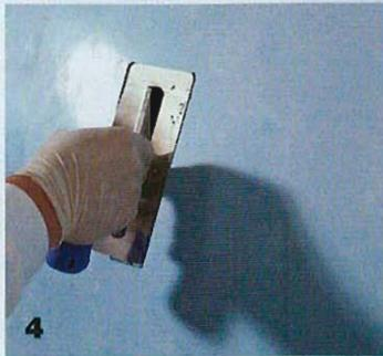
Ist die erste Spachtelschicht durchgetrocknet, beginnt nun der Auftrag der später sichtbaren Spachtelschicht:
