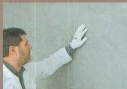
15. Der erste Auftrag ist trocken (und heller geworden). Grobe Grate abtasten und beischiefen.
