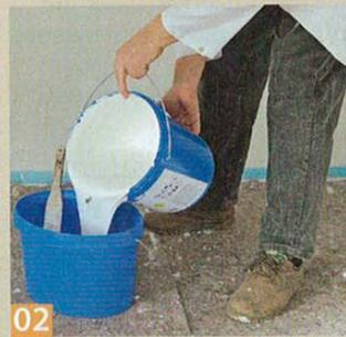
**02** Zum Grundieren saugender Untergründe wird die Kalkfarbe verdünnt. Man gießt eine bestimmte Menge in einen ...
