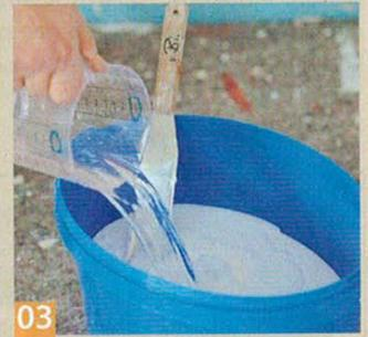
**03** ... sauberen Eimer und gießt je nach Saugfähigkeit der Wände bis maximal 20 Prozent sauberes Wasser zur Kalkfarbe.
