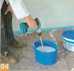
**04** Mit Hilfe eines elektrisch angetriebenen Rührkorbes werden Farbe und Wasser ausgiebig miteinander vermengt.
