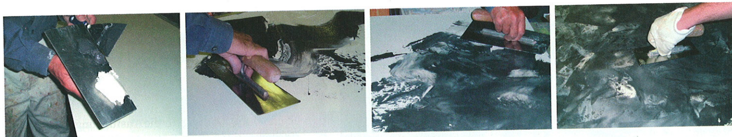
Auftrag von Kalkbuntfarben mit der Glattspachteltechnik
